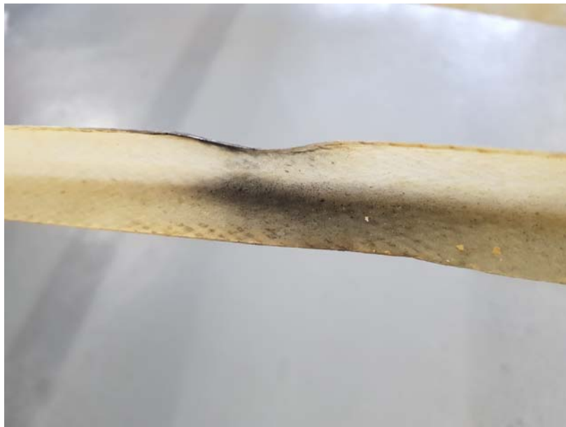
Bild 3: Abrieb an der GFK-Rippe
